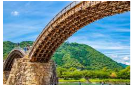
錦帯橋 画像提供：山口県観光連盟
